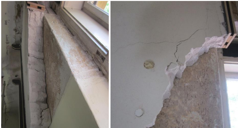
Abb. 28 Abbruch des Dämmputzes: bereits beim ersten Versuch ging zwischen Dämmung und Bestandsputz eine Fuge auf, die Dämmung konnte in großen Stücken abgelöst werden
