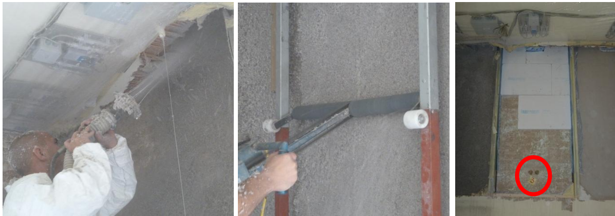
Abb. 14 Feld 1, Balken 1 & 2: Aufspritzen der bindemittelverstärkten Zellulosedämmung
