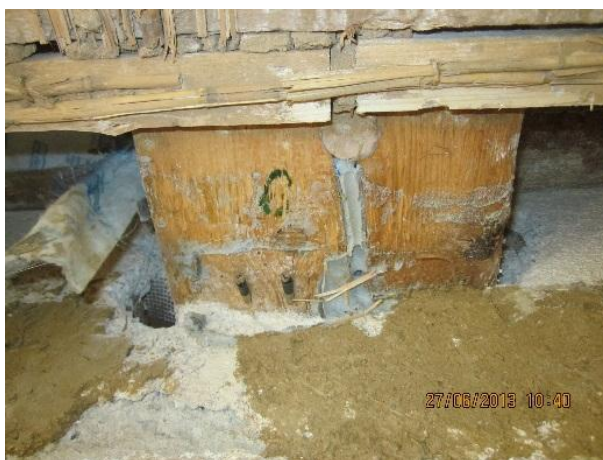
Abb. 32 Holzweichfaserplatte nach Entfernen von Dämmung und Dichtband: Verschluss eines Risses mit einem eingeleimten Holzdübel und dauerelastischer Dichtmasse
