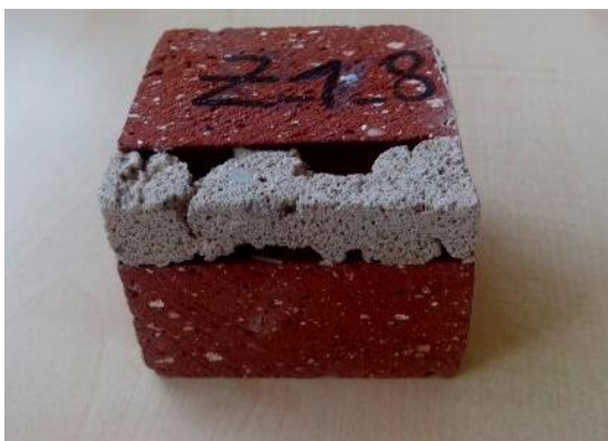
Abb. 102 Mauerwerksausschnitt mit nur teilweise aufgefüllter Mörtelfuge
